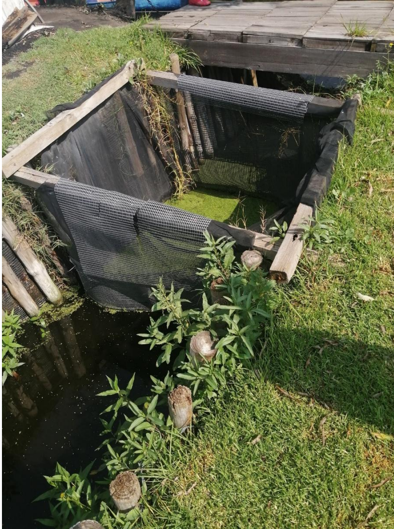
Fotografía 5.3: Biofiltro en construcción
