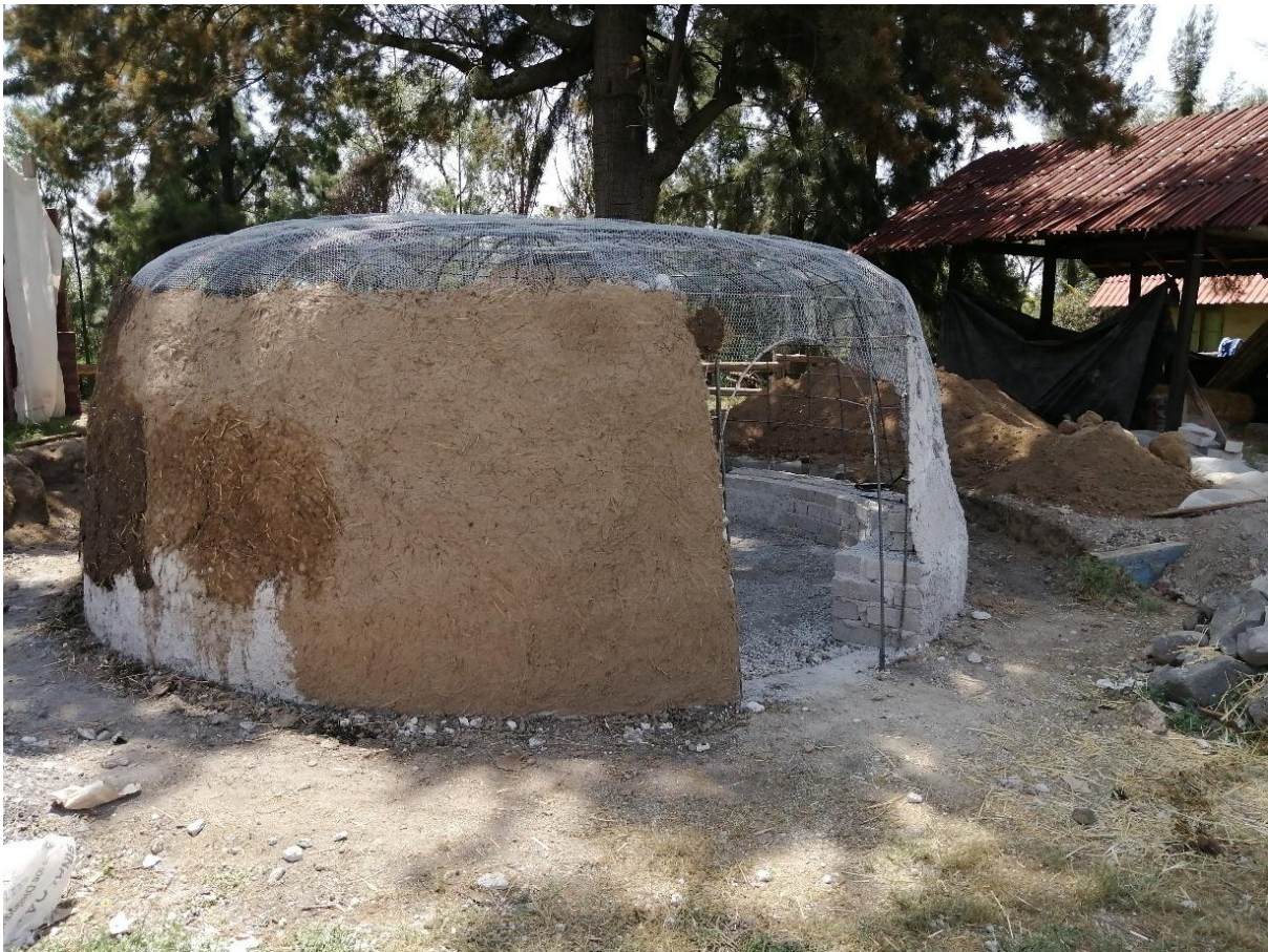
Fotografía de temazcal en construcción, acervo fotográfico propio. 17/06/2023.
